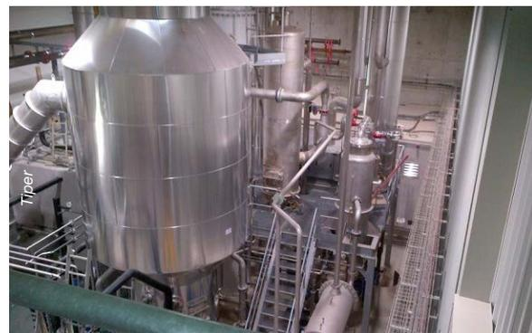
Vue d'ensemble de l'unité de méthanisation SAS Tiper (Louzy, 79). La chaîne de traitement du digestat comporte une étape d'évapoconcentration et de stripping de l'azote qui sont situés dans le bâtiment
